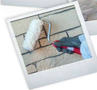
3 Des rouleaux pour reproduire le relief des pierres locales
