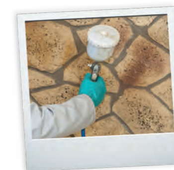
5 Une patine à appliquer "a fresco" ou "a secco"
